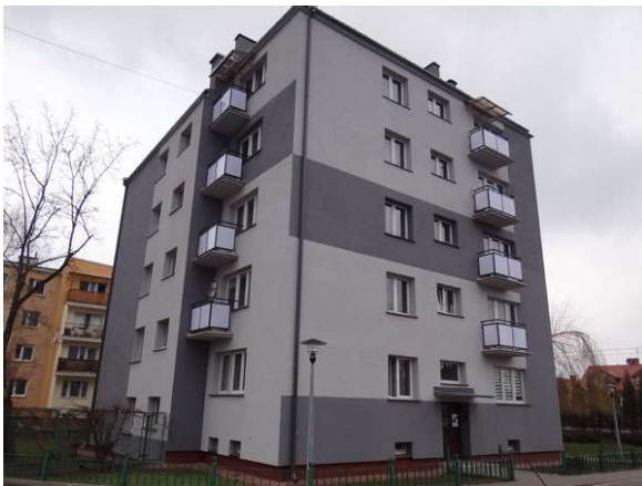
Stanovanjski blok za učitelje in sodelavce
